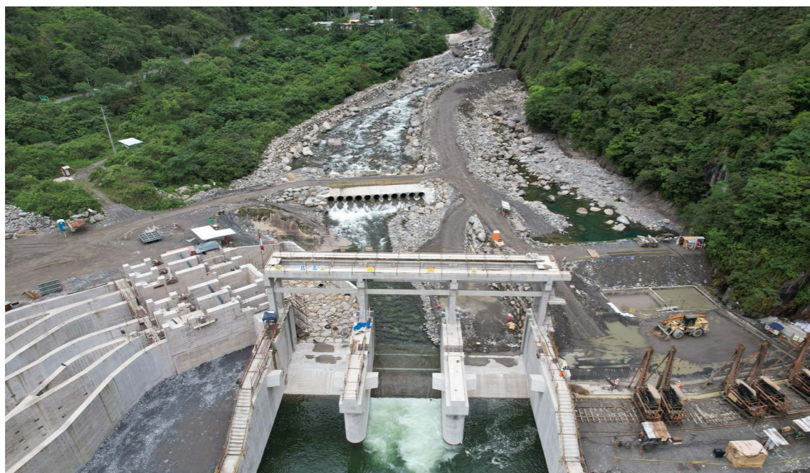
三峡集团秘鲁圣加旺水电站建设工程
