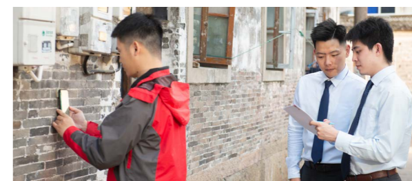
宁波市分公司工作人员通过测量、记录外墙的裂缝、空鼓等情况，避免出现因外墙空鼓而导致的脱落事件，保障居民财产和生命安全
