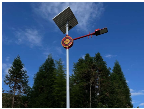
云南省德宏州分公司在驻点村安装太阳能路灯
