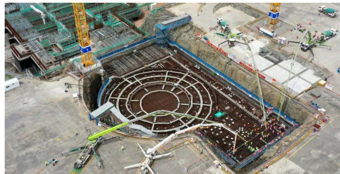
三门核电二期工程
